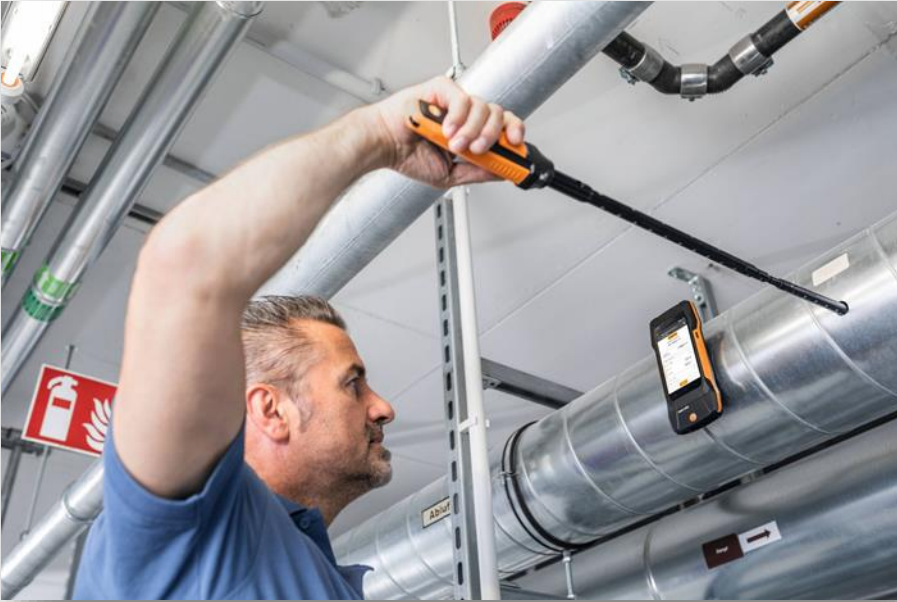
Tubo de Pitot para medir velocidad del aire en un ducto
